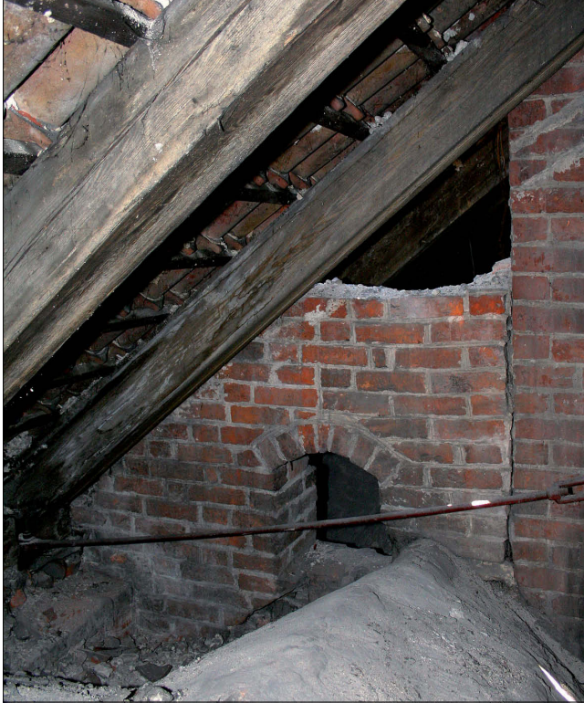
Il. 4. Kaplica Krzyża Św., półszczyt od strony wschodniej świadczący, że kaplica ta powstała jako pierwsza w rzędzie południowym i jakiś czas stała niezależnie.
