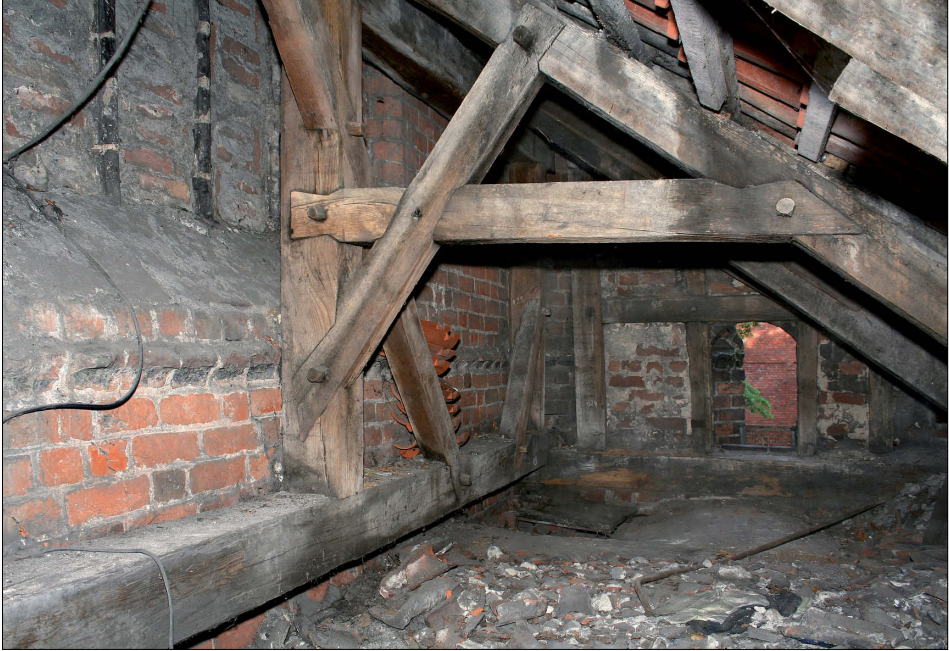
Il. 26. Kaplica Ogrójca, oryginalna więźba dachowa i szczyt w konstrukcji szkieletowej z roku 1508 (datowanie dendrochronologiczne). Fot. A. Konieczny, 2008 r. (stan sprzed remontu)
