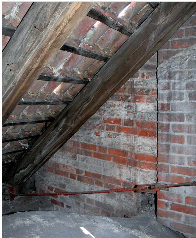
Il. 7. Kaplica św. Anny, półszczyt z malarsko opracowanym licem (od wsch.) świadczy, że powstała ona jako druga w rzędzie południowym i jakiś czas stała niezależnie. Widoczny ślad po pierwotnym dachu pulpitowym kaplicy. Fot. A. Konieczny, 2007 r.
