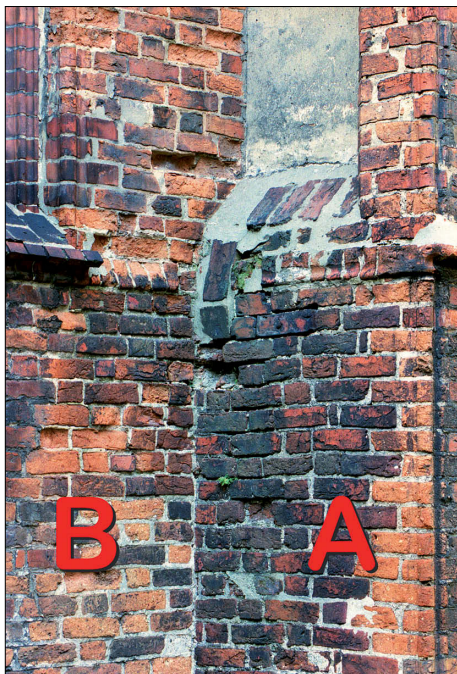
Il. 11. Kaplica Matki Boskiej Różańcowej. Szkarpa zachodnia (z blendą) bez strzępi na dowiązanie ściany kaplicy sąsiedniej: A – szkarpa zachodnia kaplicy Matki Boskiej Różańcowej, B – ściana południowa kaplicy św. Walentego. Fot. A. Koniczny, 2004 r.
