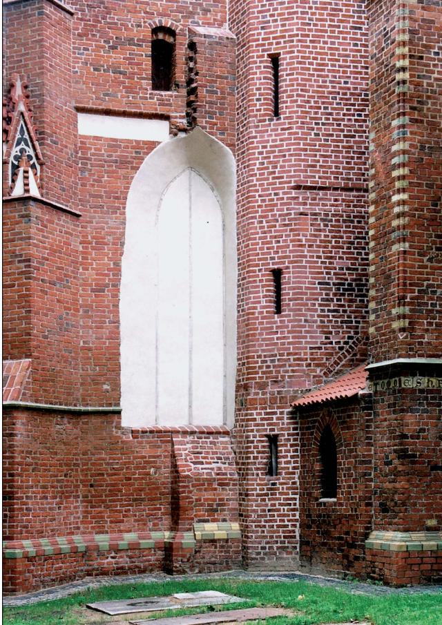
Il. 12. Elewacja wschodnia nawy południowej kościoła Świątojakubskiego. Okno wykute wtórn timerie, zapewne w czasie budowy kaplic bocznych, (później zamurowane). Fot. A. Konieczny, 2004 r.
