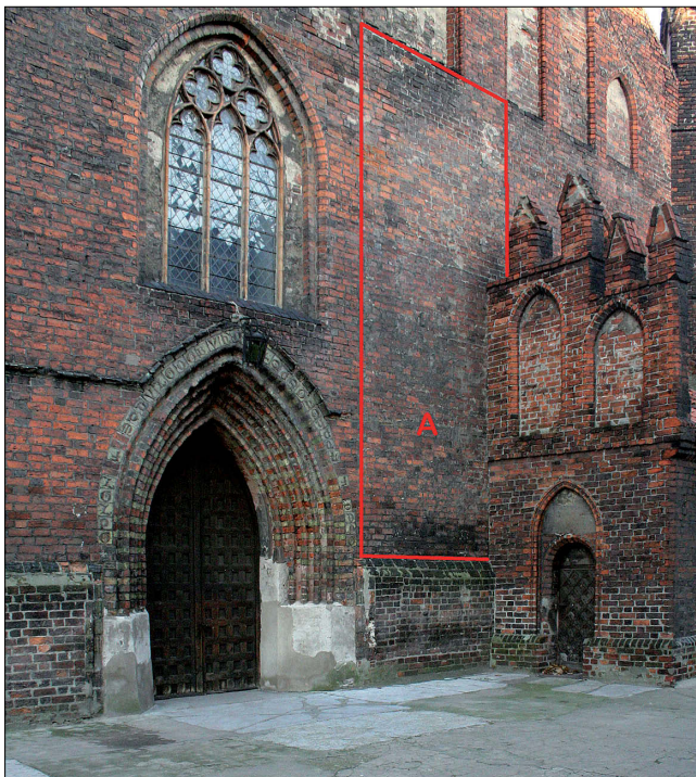
Il. 1. Kościół św. Jakuba w Toruniu, fasada zachodnia – lokalizacja gotyckiego malowidła; A – skuty gzyms kapnikowy. Fot. A. Konieczny, 2008 r.
