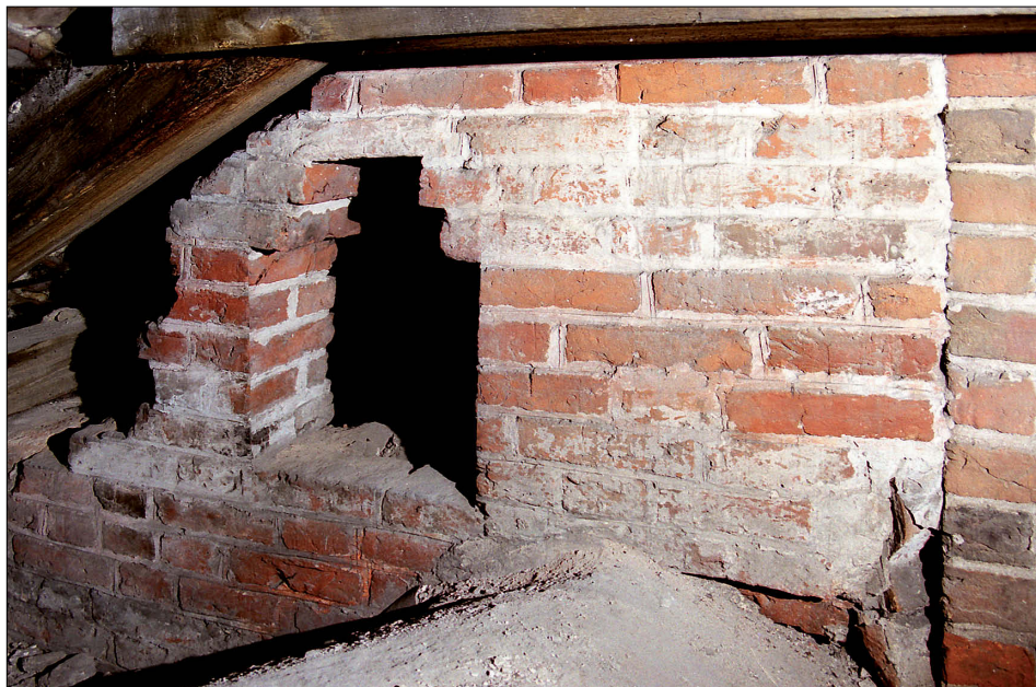
Il. 13. Kaplica św. Antoniego, półszczyt z malarsko opracowanym licem (od zach.) świadczy, że powstała ona, wraz z sąsiednią kaplicą Św. Rodziny, jako pierwsza w rzędzie północnym.
