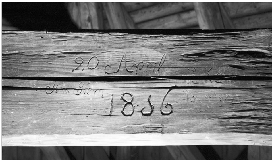
Il. 7. Gliwice-Ostropa, dawny kościół parafialny pw. św. Jerzego, wieża. Oczep środkowy izbicy z widocznymi gniazdami po złączach ciesielskich pierwotnej konstrukcji dachu wieży. Fot. A. Konieczny 2009
