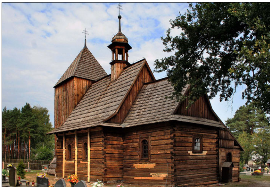
Il. 9. Brusiek, kościół filialny pw. św. Jana Chrzciciela. Widok od południowego wschodu. Ściany kościoła po zdjęciu gontu w trakcie remontu w 2009 r. Fot. A. Konieczny 2009
