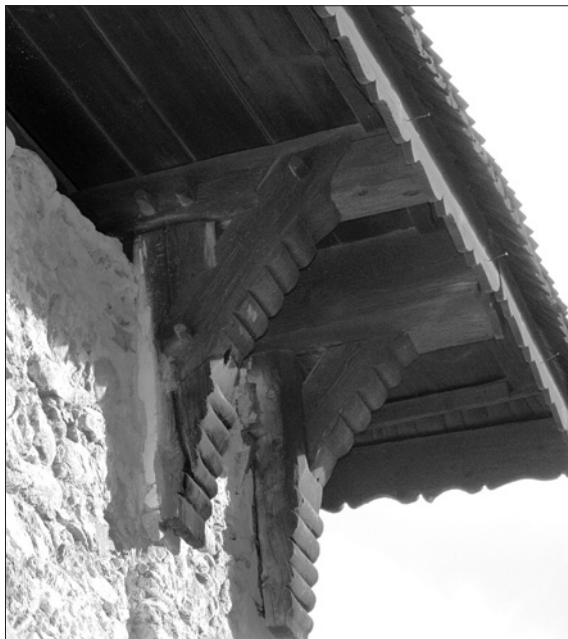
Il. 2. Sądów, kościół parafialny pw. św. Józefa. Wolno stojąca dzwonnica. Elewacja wschodnia z dekoracyjnymi zaczepami dopasowanymi do grubości muru dolnej kondygnacji. Fot. A. Konieczny 2008
