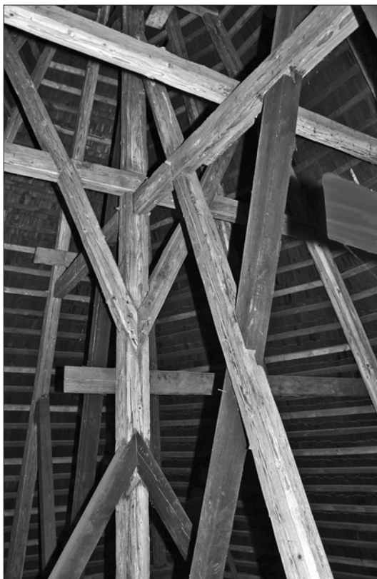
Il. 3. Sieroty, kościół parafialny pw. Wszystkich Świętych. Więźba dachowa nad prezbiterium w widoku od północnego zachodu. Fot. A. Konieczny 2008
